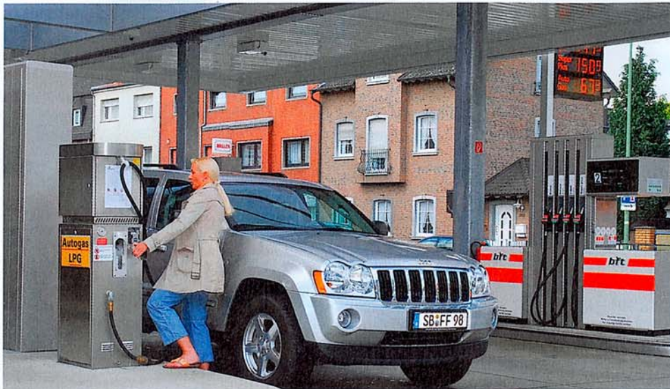
Tanken in der ersten Reihe: Wo möglich, sollte die Autogas-Zapfsäule neben den anderen Kraftstoffen stehen.
